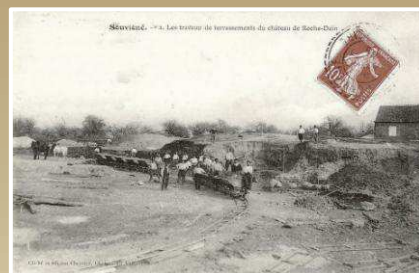
Travaux de terrassement
